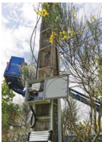
Coffret monitoring pour poste sur poteau
