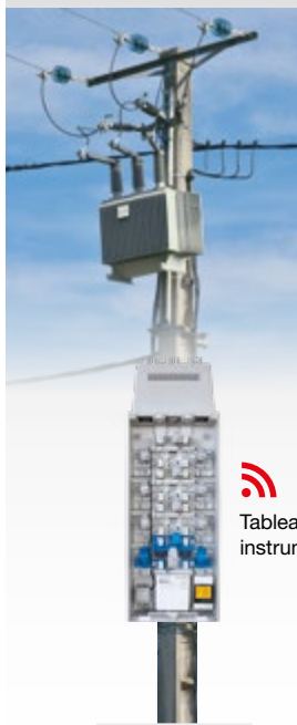
Transformateur haut de poteau TPC
