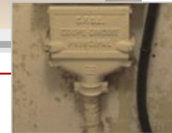
Exemple de pied de colonne
